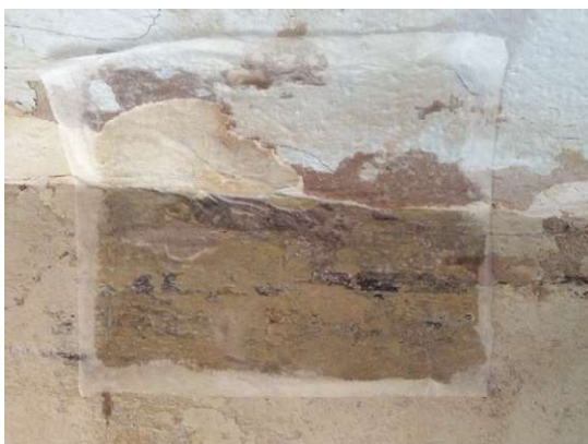
1 Mit dem Festigungsmittel eingestrichenes Japanpapier auf der zu festigenden Wandpartie (Dachschräge oberhalb der Toilettenwand)
