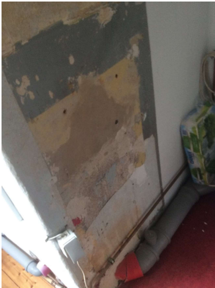
4 Die Wand zur Außentoilette. Dies ist der Bereich, der vorrangig bearbeitet werden soll.
