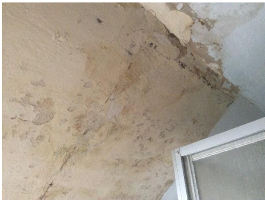
2 Die betreffende Wandstelle nach Abnahme des Japanpapiers
